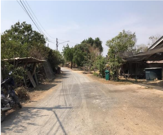
๖๖.โครงการก่อสร้างถนนคอนกรีตเสริมเหล็ก บริเวณบ้านท่าหว้า หมู่ที่ ๖
